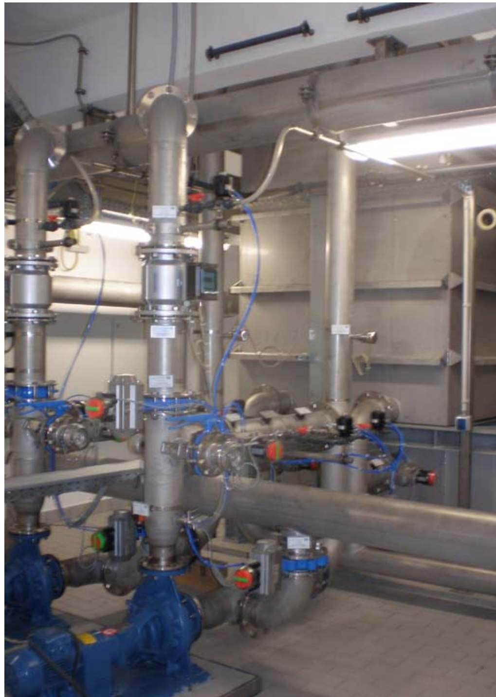
Ansicht der Pumpenkammer
