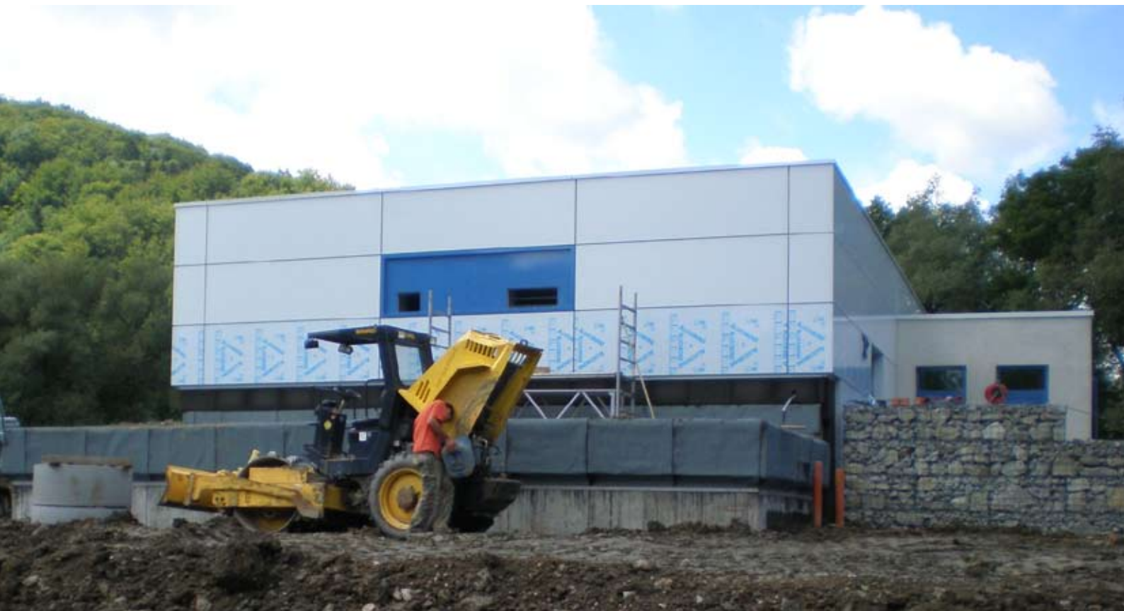
Ansicht des neuen Wasserwerkes
