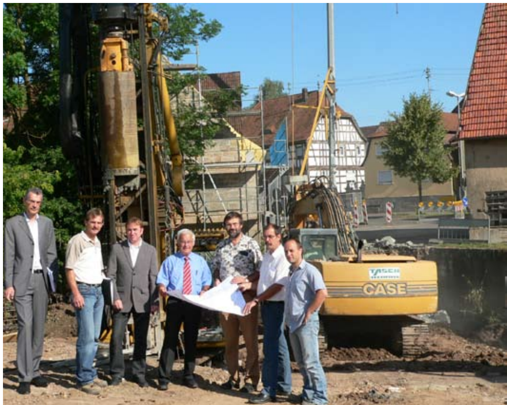
Über die laufenden Bauarbeiten bei dem Brückenneubau in Bundorf-Neuses informierten sich (von links) Dipl.Ing: Albrecht Kitz vom planenden Büro BAURCONSULT, Haßfurt, der stellvertretende Leiter der Kreistiefbauverwaltung des Landkreises Hubert Schramm, Bürgermeister Hubert Endres von Bundorf, Landrat Rudolf Handwerker, Norbert Dietmeyer vom Staatlichen Bauamt Schweinfurt, Axel Meffert als Leiter der Kreistiefbauverwaltung und Bauleiter Volker Götz von der Firma Adam Tasch, Schweinfurt.
