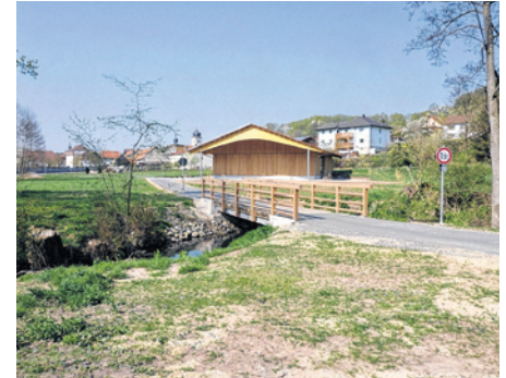
Über das Brückenbauwerk des Ebelsbach mündet der Radweg in Gleisenau ein mit der Kirche und dem Ort im Hintergrund. Foto: Ziegler
