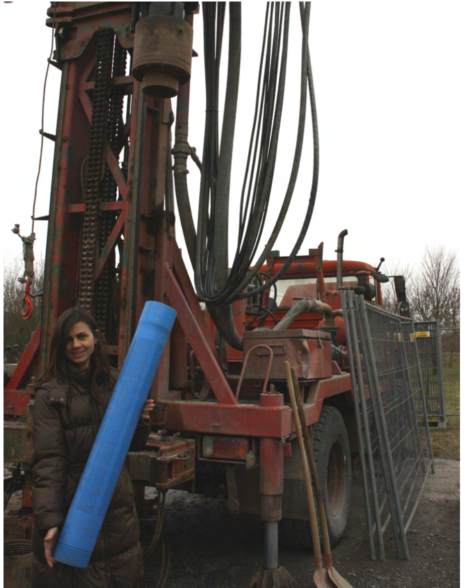
Geologin Heike Kraus mit einem der Filterrohre, die in eines der beiden Bohrlöcher gesetzt werden. Foto presse
