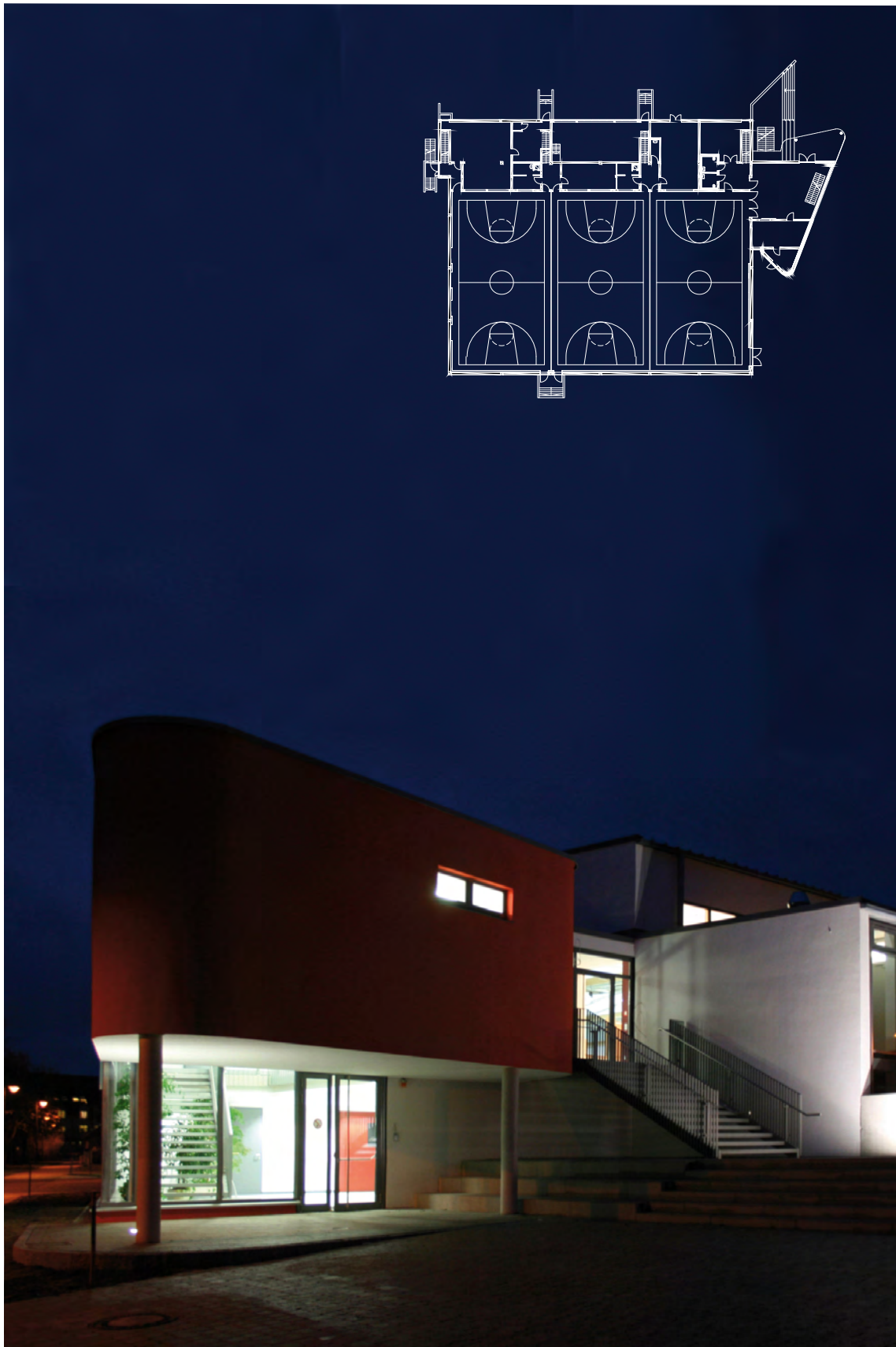
Ansicht Eingangssituation - Foyergebäude
