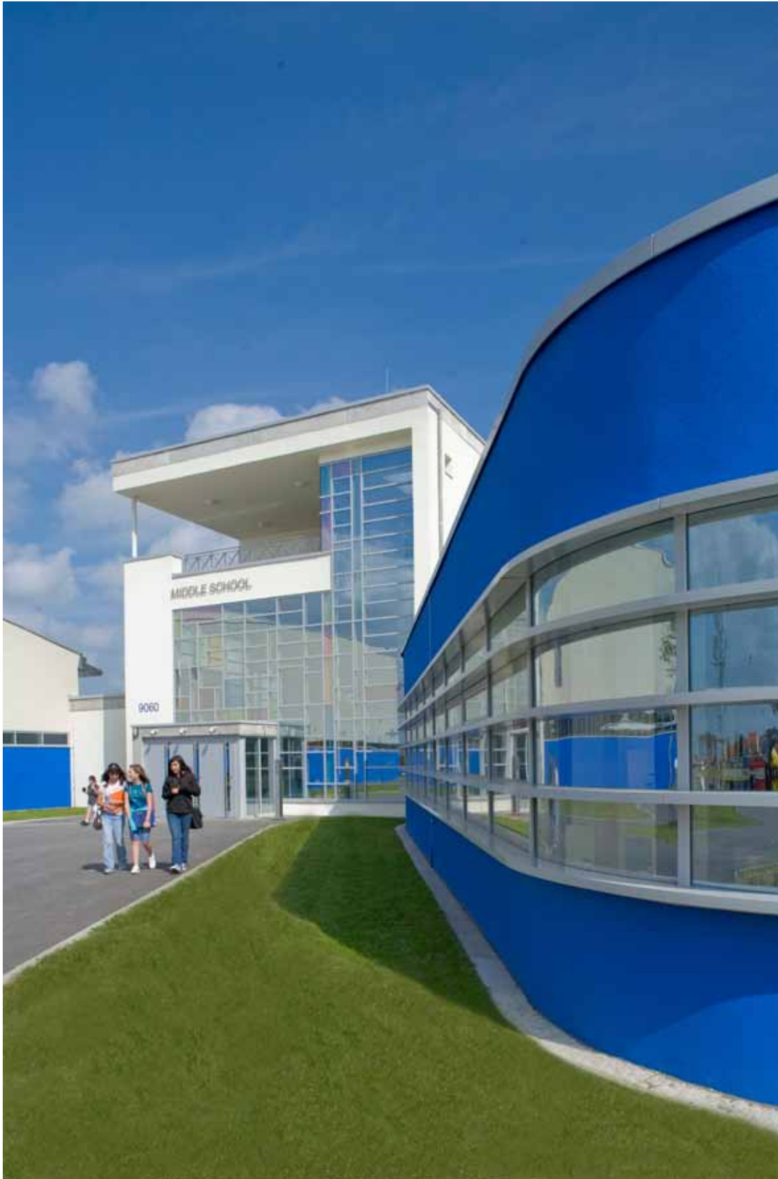
Ansicht Eingangsbereich Elementary School
