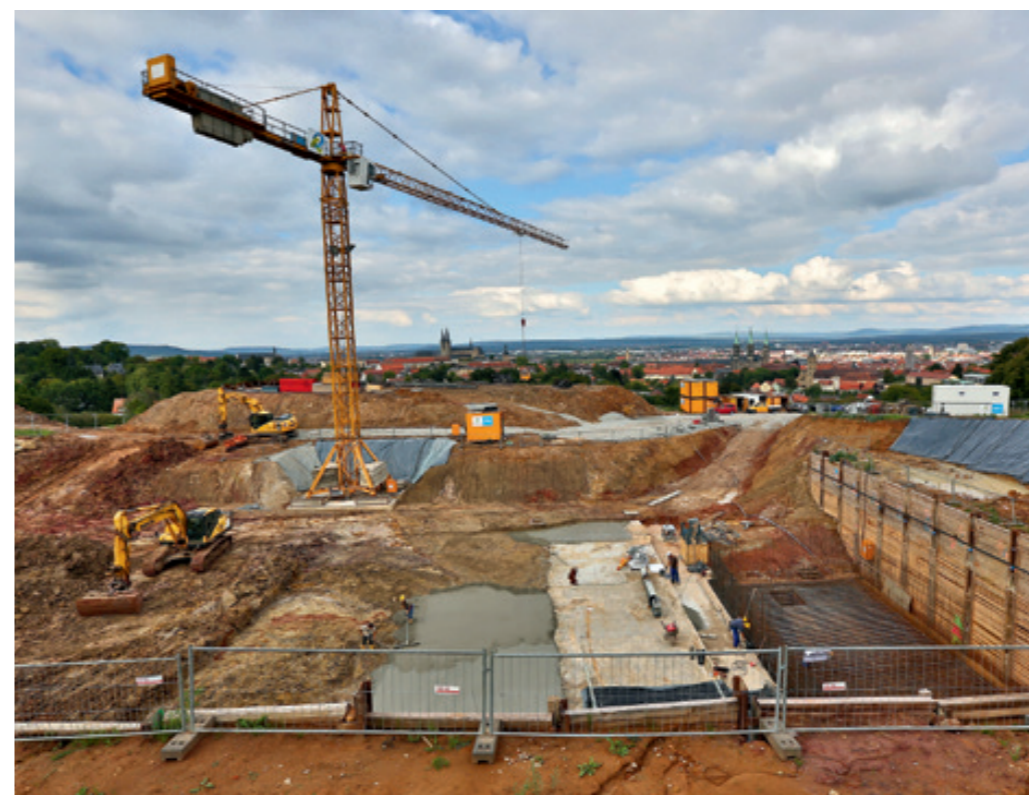
Abb. 2: Bau des Hochbehälters Altenburg
