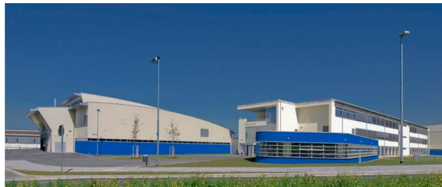
Ansicht der Middle School mit Turnhalle Mediathek und Eingangsbereich
