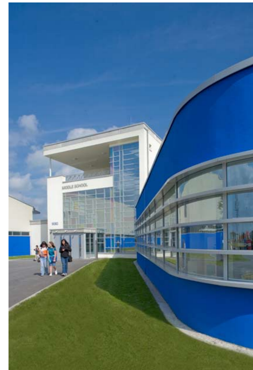
Erschließungsbereich der Middle School
