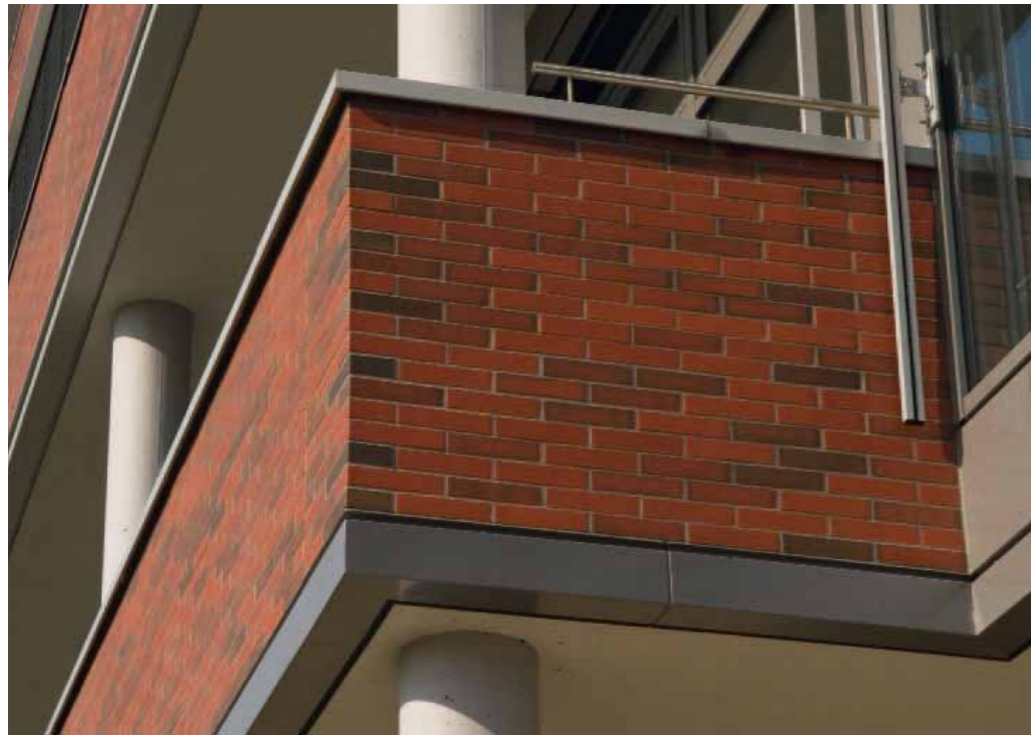
Links: Röben Klinker-Riemchen lassen sich so perfekt verarbeiten, dass kein Unterschied im Vergleich zu massivem Mauerwerk erkennbar ist. Besonders deutlich zu sehen an den Mauerecken – mit Winkelriemchen mustergültig ausgeführt.
