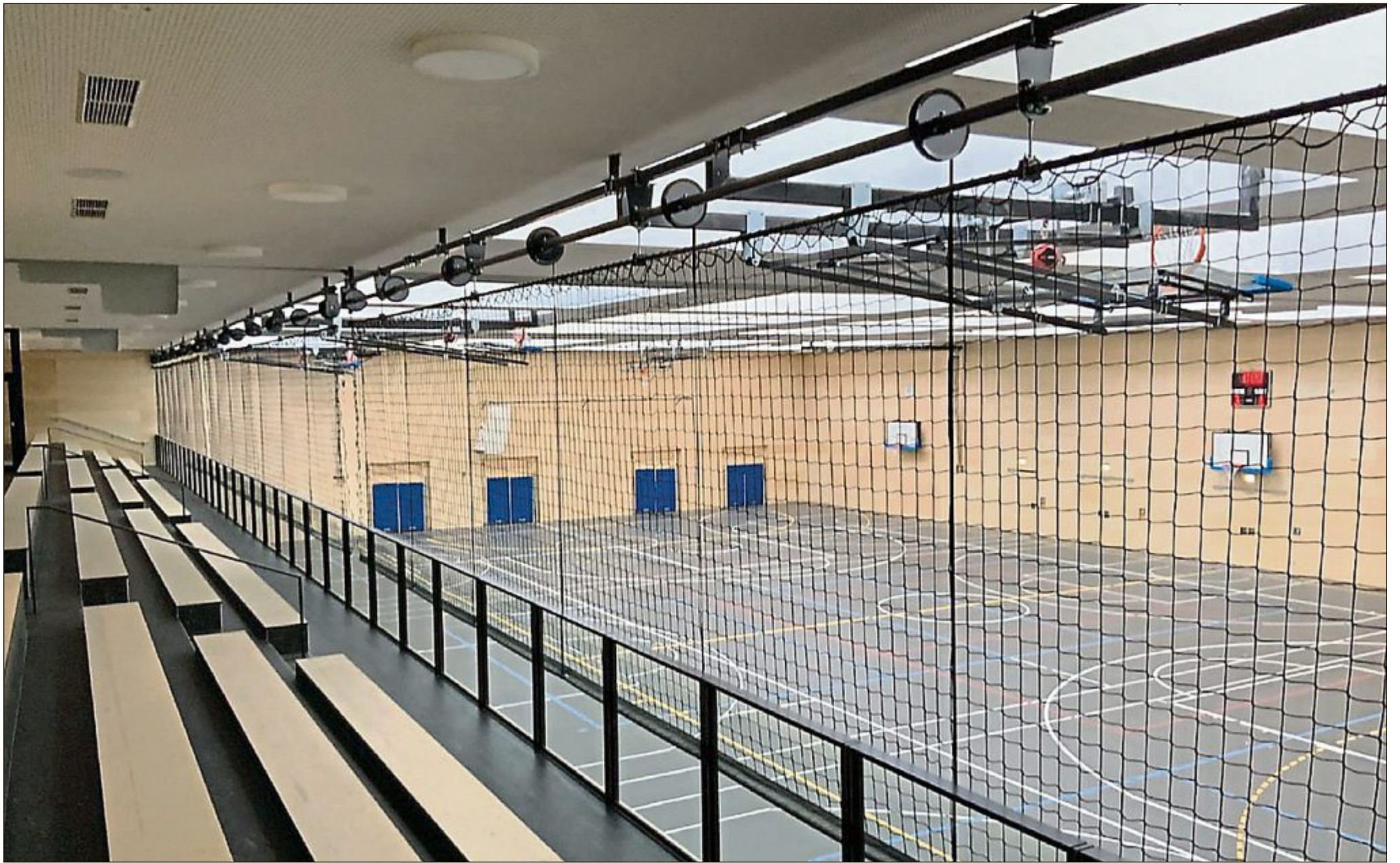
Blick in die generalsanierte Münnerstädter Mehrzweckhalle.
