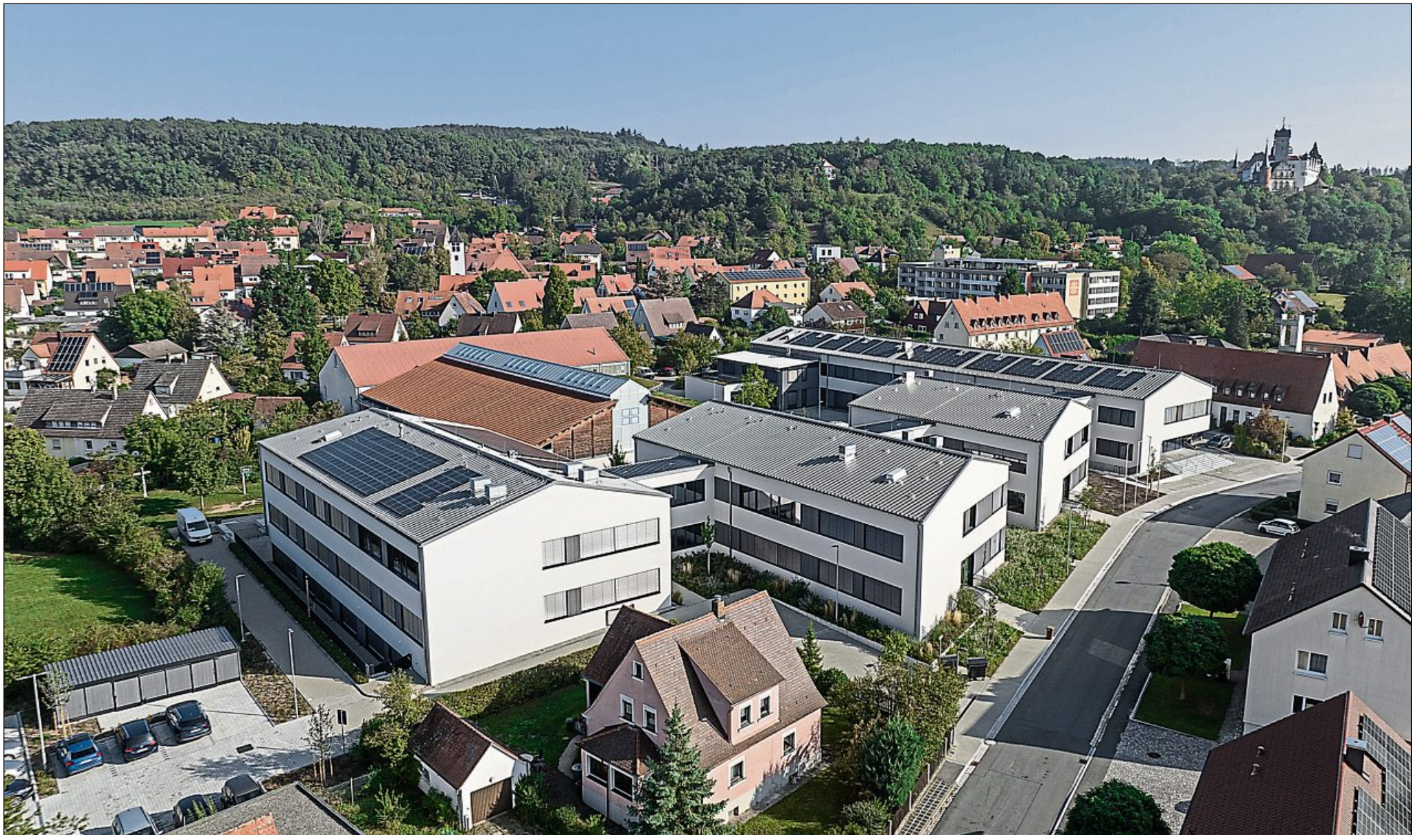
Der Neubau des Gymnasiums Scheinfeld besteht aus vier baugleich verbundenen Schulgebäuden.
