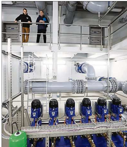
Der neue Hochbehälter speichert rund 8,4 Millionen Liter Trinkwasser.
