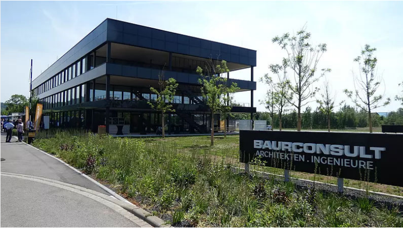
Foto: Christian Licha | Nach eineinhalb Jahren Bauzeit wurde das neue Firmengebäude des Architektur- und Ingenieurbüros Baur Consult nun offiziell seiner Bestimmung übergeben.
