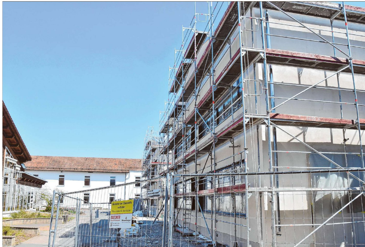
Die Arbeiten für den zweiten Bauabschnitt – die beiden Klassenzimmer-Gebäude – des Scheinfelder Gymnasiums kommen planmäßig voran. Der dritte Abschnitt, der mit dem Abriss des Goethe-Baus im Bildhintergrund in den Sommerferien beginnt, wird bereits vorbereitet. Foto: Andreas Reum
