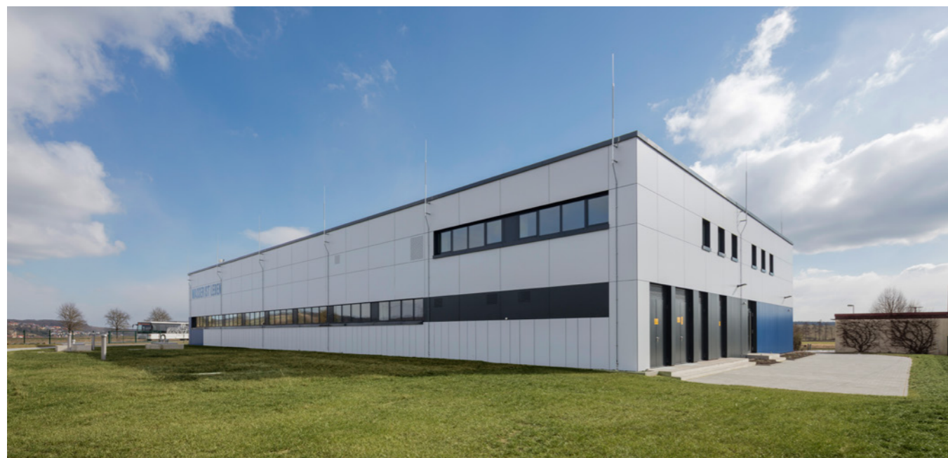
Außenansicht Wasserwerk Weyer
