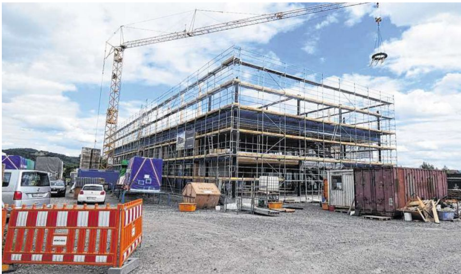
Richtfest bei BaurConsult: Mit den vorgefertigten Holzmodulen konnte die Bauzeit vor Ort auf bisher drei Monate verkürzt werden. FOTOS: CHRISTIAN LICHA
